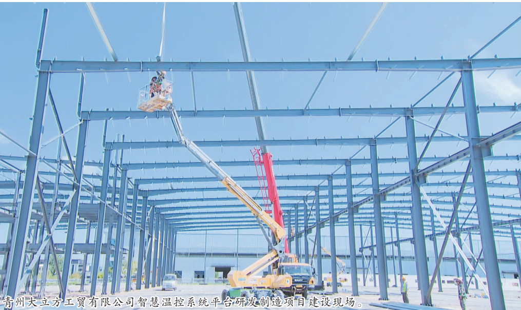
青州大立方工贸有限公司智慧温控系统平台研发制造项目建设现场。
