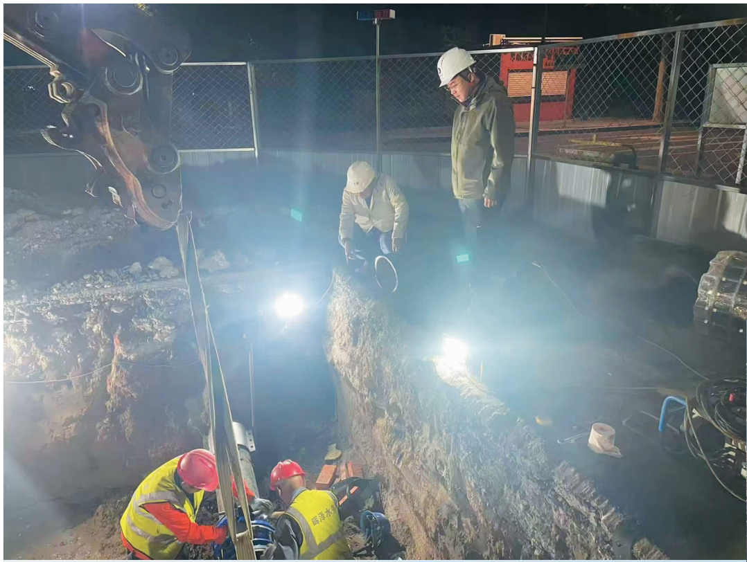
为进一步提升城市供水保障能力,市住建局组织供水企业对西关路实施老旧供水管网提升改造工程。施工中,面对地下管线分布复杂、施工空间小、人流量大等诸多不利因素,市住建局科学调配人员、机械,加班加点,倒排工期,全力以赴加快工程进度。截至目前,该工程已完成90%,预计可提前10天完工。(□通讯员 报道)
