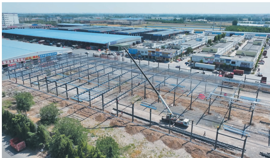
青州传弘公共分拨配送中心项目建设现场。
