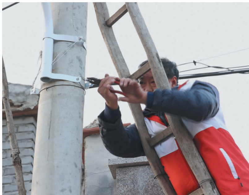
志愿者安装太阳能路灯
